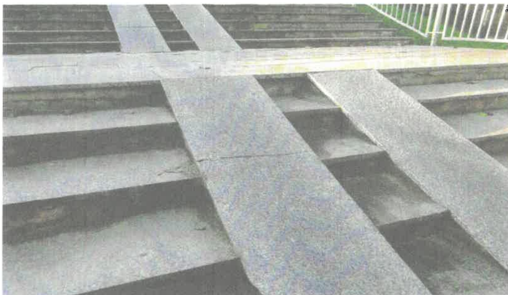
Fot. 6 Widok podjazdu dla wózków dziecięcych do demontażu i wykonania w nowym miejscu wg projektu.
