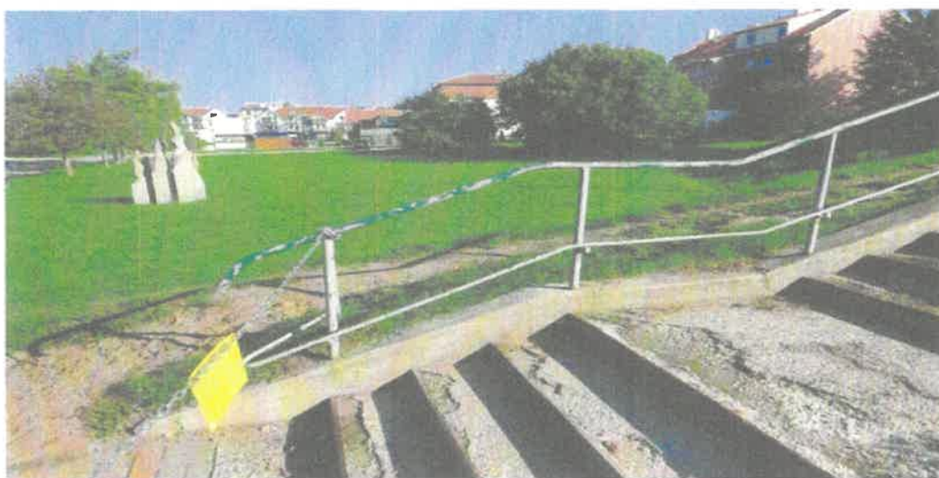
Fot. 9 Widoczne łuszczenie betonu. Balustrady do demontażu.
