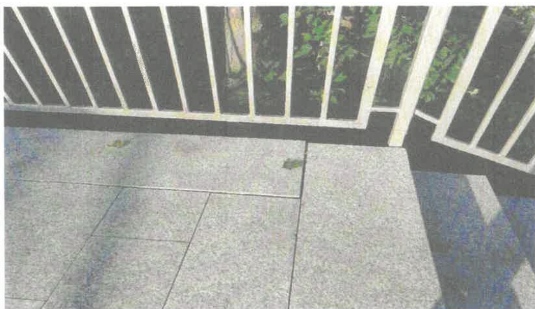
Fot. 7 Widok spocznika z małych elementów. Projektuje się większe płyty granitowe w celu wyeliminowania klawiszowania.
