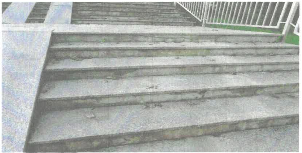
Fot. 3 Widok łuszczącego betonu podstopni. Wilgoć i brak spadku płyt granitowych powoduje wnikanie wody w strukturę.
