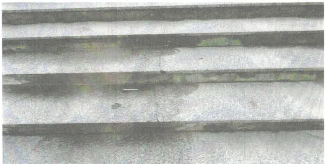
Fot. 5 Widok popękanych płyt granitowych stopni.
